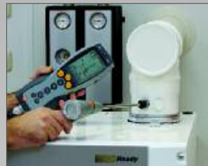
Verkleidung montieren und Verbrennungswerte kontrollieren
