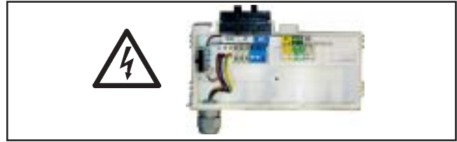
Рис.: Клеммная коробка: Опасность поражения электрическим током
