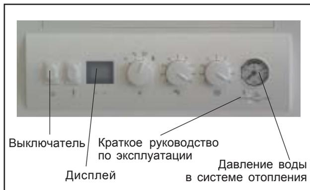
Рис.: Общий вид устройства регулирования
