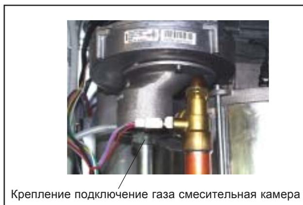
Рис.: Крепление подключение газа смесит. камера
