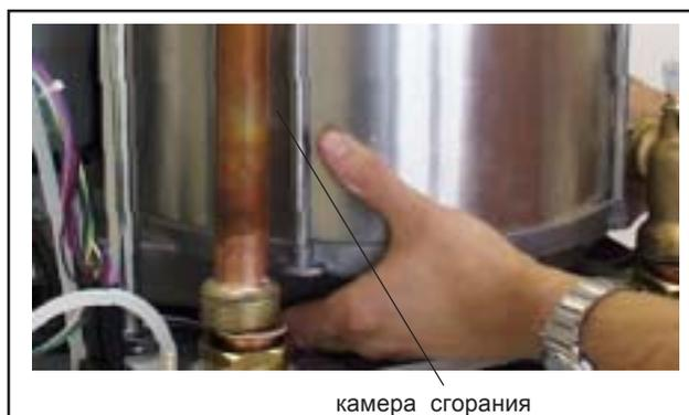
Рис: Камера сгорания
