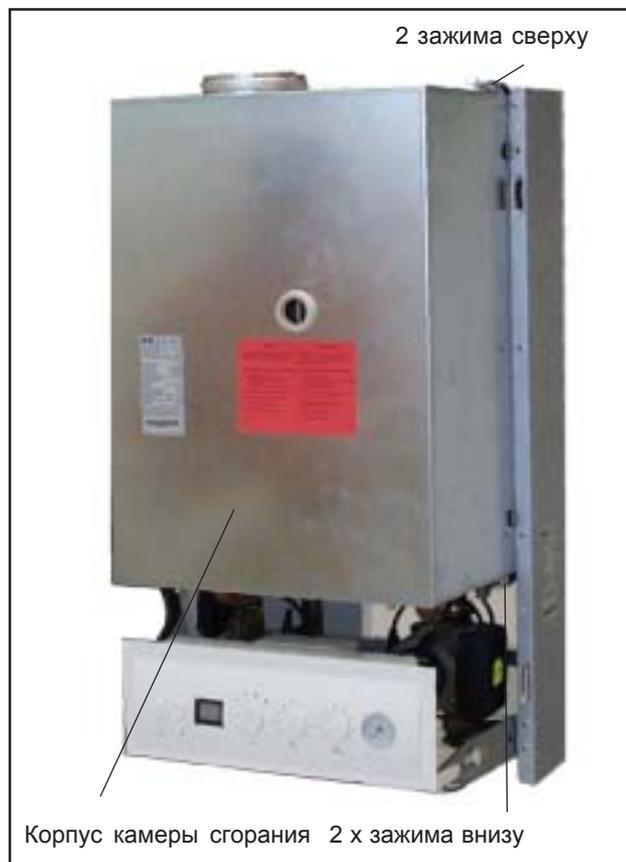
Рис.: Газовый настенный конденсационный котел со снятой лицевой обшивкой
