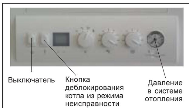
Рис.: Общий вид устройства регулирования
