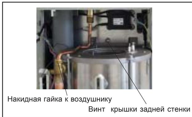
Рис.: Накидная гайка / Крышка задней стенки
